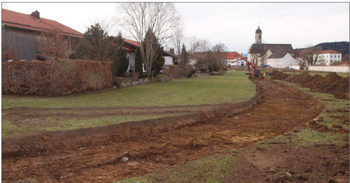
Abb. 23 Rotlageabtrag im Bereich der künftigen Baustraße gegen Süden.
