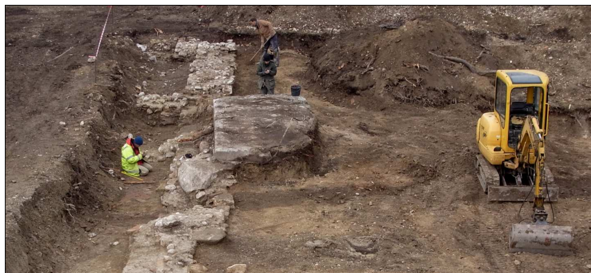
Abb. 9 Freilegung und Dokumentation des Prälaturfundaments und dessen Umfeld.
