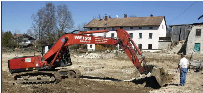
Abb. 8 Oberbodenabtrag mit dem Kettenbagger der Fa. Weiß aus Schechen.
