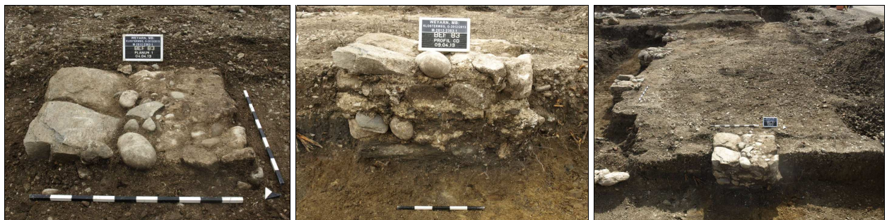
Abb. 30 Punktfundament 83 im Planum, Profil und in der Übersicht.
