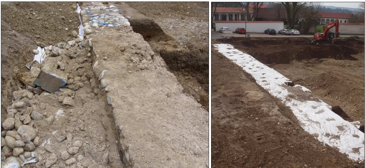
Abb. 44 Links: Abtrag der zu hohen Bereiche. Rechts: mit Geotextil eingeschlagenes Fundament.
