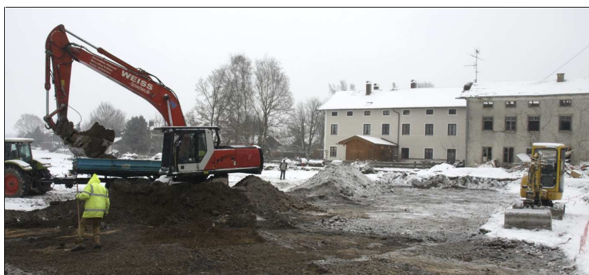
Abb. 10 Oberbodenabtrag bei winterlicher Witterung am 26.03.2013.
