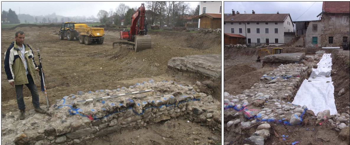
Abb. 43 Links: Markierung der abzutragenden Steine mit Sprühfarbe. Rechts: Einbringen von Geotextilvlies auf der SSO-Seite.
