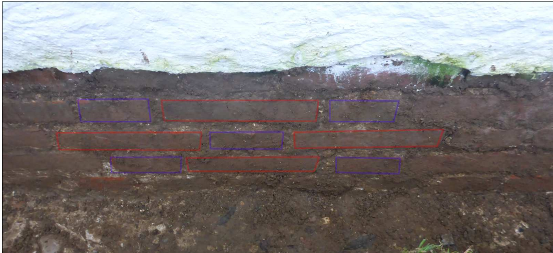
Abb. 17 Mauerverband mit Läufern und Bindern im Wechsel.
