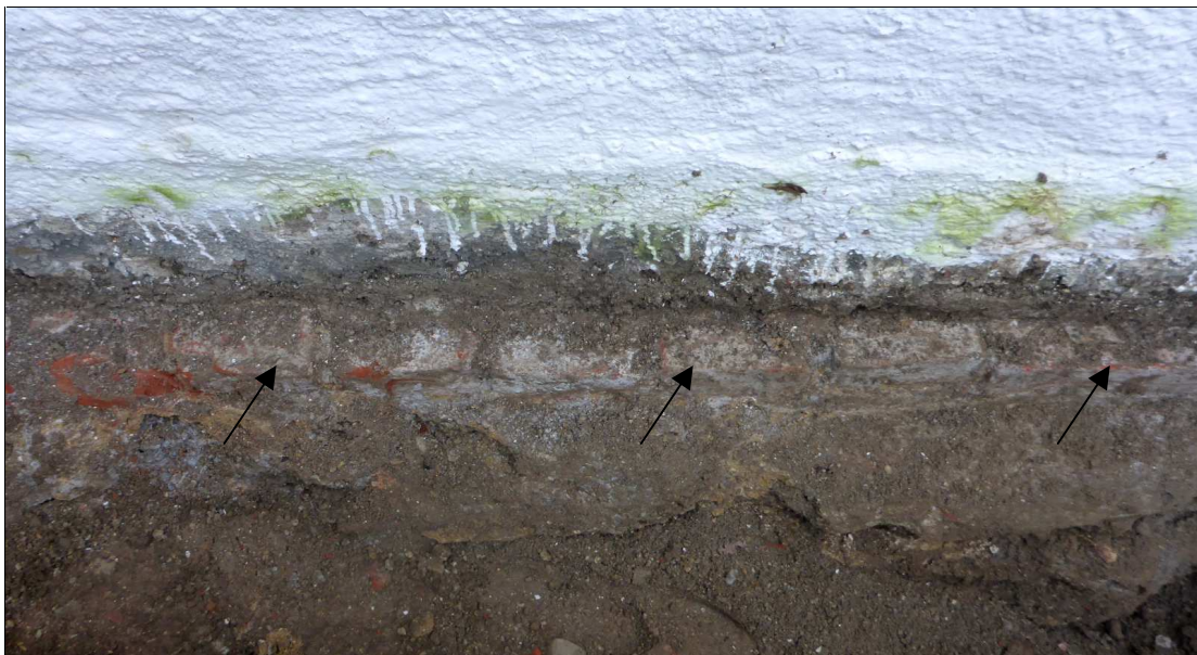
Abb. 20 Von der Orientierung der Langhausmauer abweichende Ziegellage.
