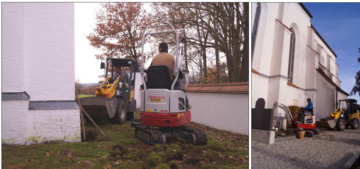
Abb. 2 Aushubarbeiten auf der Nord- und Südseite des Langhauses.
