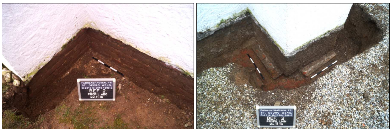
Abb. 16 Links: Unverputztes Mauerwerk im Bereich der westlichen Lisene des Chors (Profil 2 ABC). Rechts: Verputzte Fundamentzone des Mauerwerks an der SW-Ecke des Turms (Profil 2 LMN).
