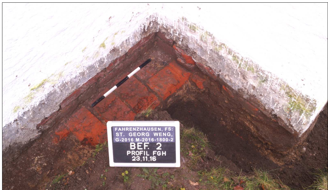
Abb. 18 Sauber aus Ziegeln gesetztes Fundament im mittleren Bereich des Langhauses (Profil FGH).
