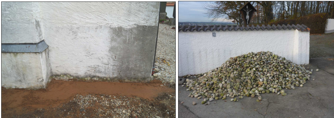
Abb. 5 Links: verdichteter Dernothon an der westlichen Sakristeiwand. Rechts: für die spätere Wiederausbringung zwischengelagerter Grobkies.
