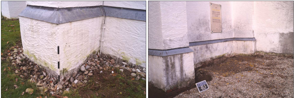
Abb. 15 Links: Sockelzone einer Lisene auf der Nordseite. Rechts: Sockelzone auf der Südseite.
