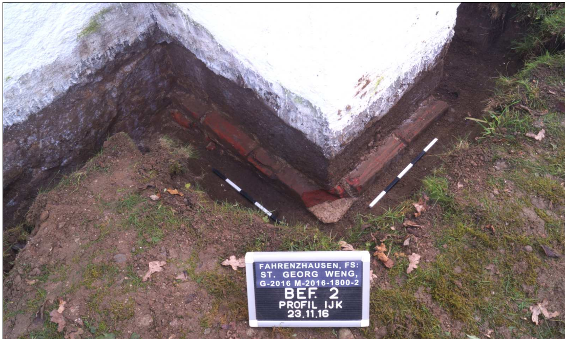
Abb. 19 Fundamentvorsprung an der Mauerblende des 2. Langhausjochs (Profil IJK).
