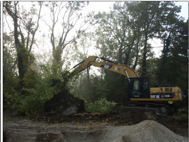
Abb. 2 Links: bereits vor Grabungsbeginn tiefenentwürfelte Baugrube des ehemaligen Danfoss-Gebäudes. Rechts: Umlegen des alten Baumbestandes mit dem Sortiergreifer des Kettenbaggers.
