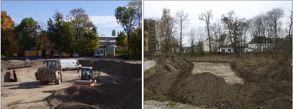
Abb. 2 Links: bereits vor Grabungsbeginn tiefenentrüpelte Baugrube des ehemaligen Danfoss-Gebäudes. Rechts: Flächenöffnung in nicht asphaltiertem Bereich.
