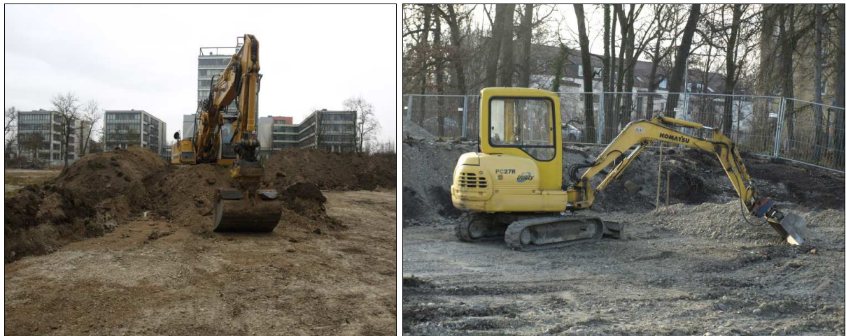
Abb. 6 Links: Oberbodenabtrag mit dem großen Kettenbagger Rechts: Komatsu Minibagger.
