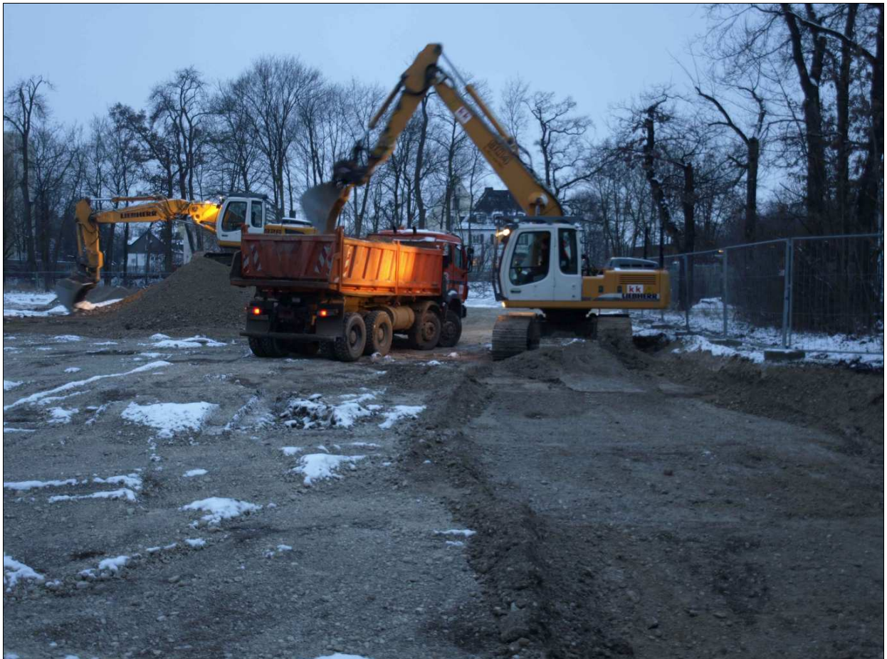
Abb. 25 Glück gehabt: Letzte Flächenöffnungen vor dem nahenden Kälteeinbruch.
