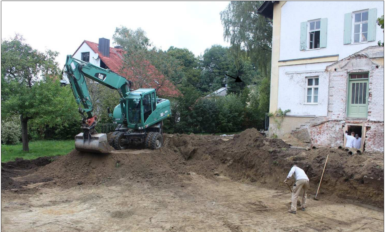
Abb. 7 Oberbodenabtrag durch Herrn Martin Heinzinger.
