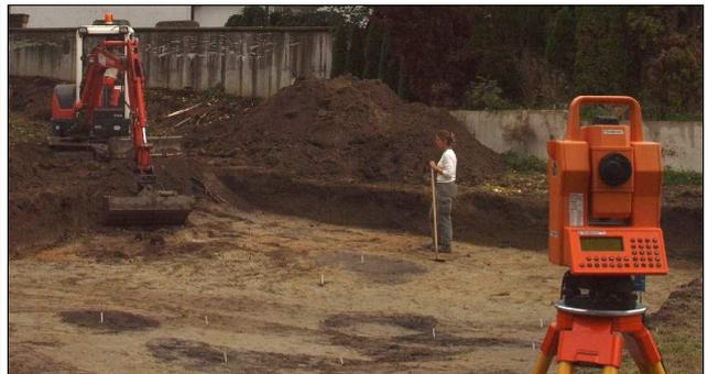
Abb. 11 Links: Fest- und Anschlusspunkte der Vermessung. Rechts: Tachymeter.
