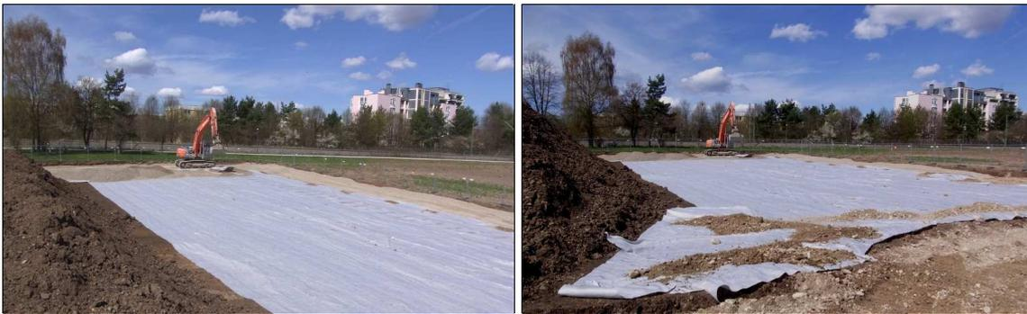
Abb. 8 Überdeckung der Rotlage mit Geotextilvlies als Unterbau für das Kieslager.
