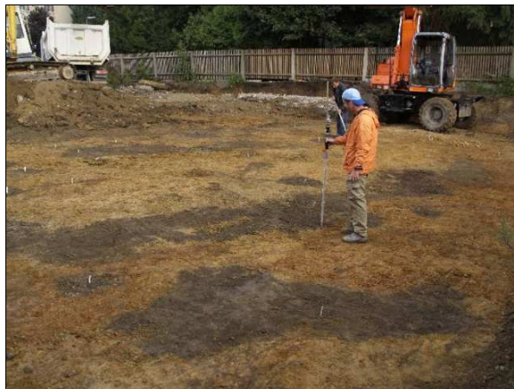
Abb. 7 Vermessung des Planums. Mobilbagger im Hintergrund.
