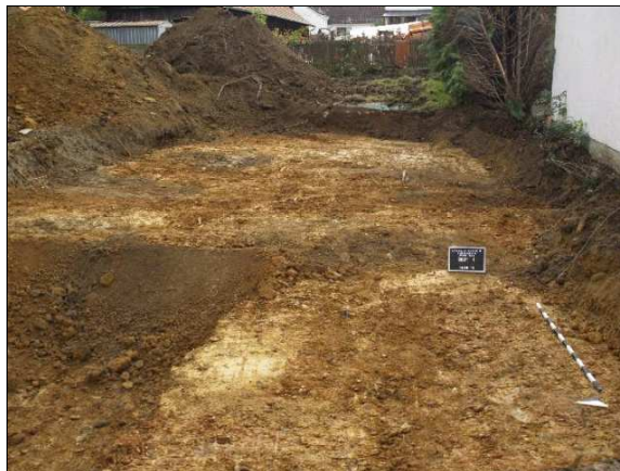
Abb. 6 Feinplanie mit zwischenzeitlich abgelagertem Humus- und Rotlagematerial.
