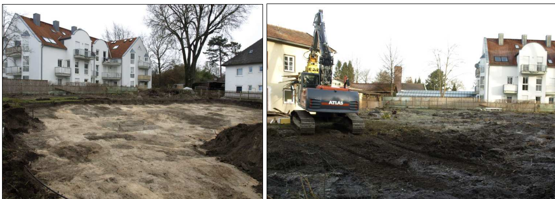
Abb. 2 Links: Teilgeöffnete Fläche mit Siedlungsbefund. Rechts: beginnender Abriss des Altbestandes.
