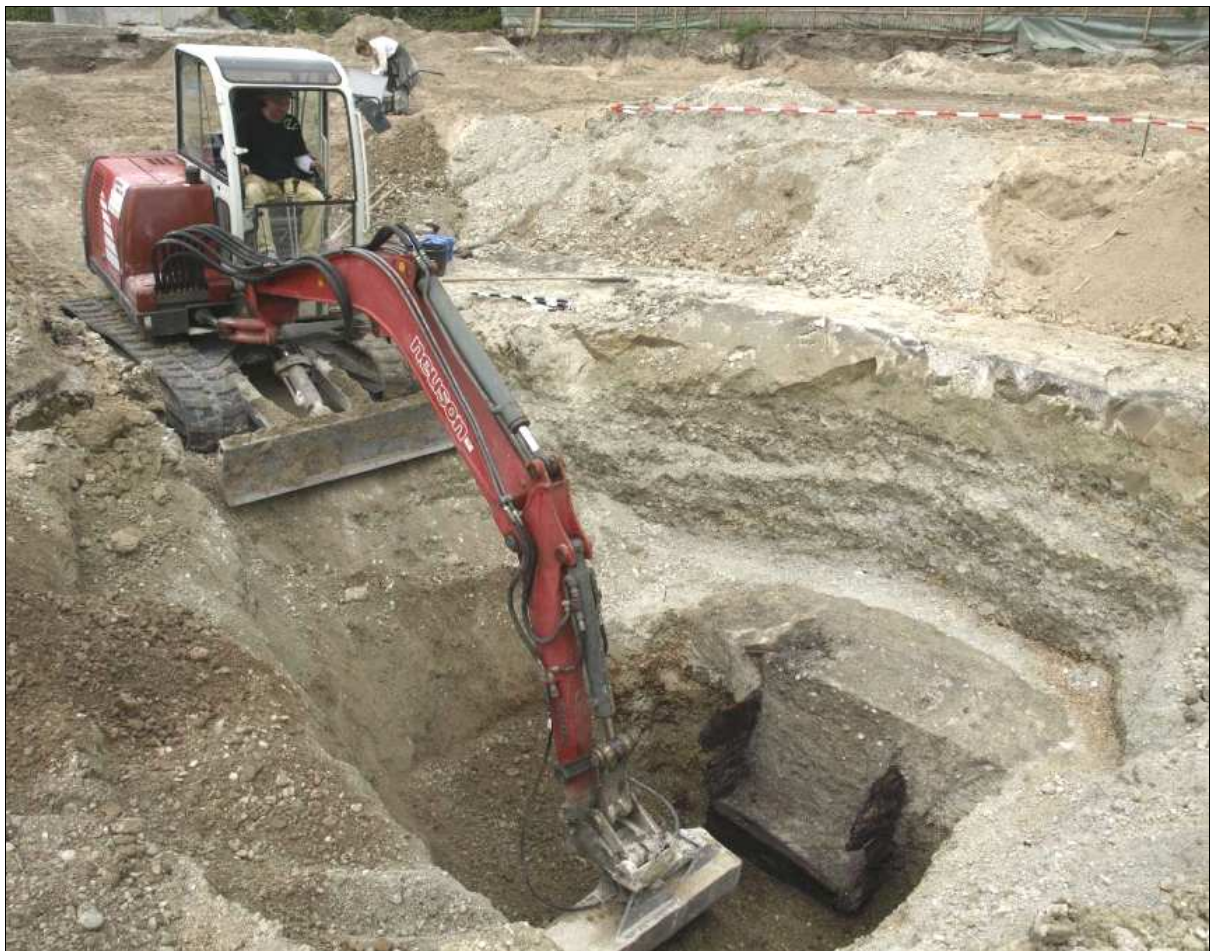
Abb. 7 Baggerarbeiten am spätmittelalterlichen Brunnen Bef. 14.
