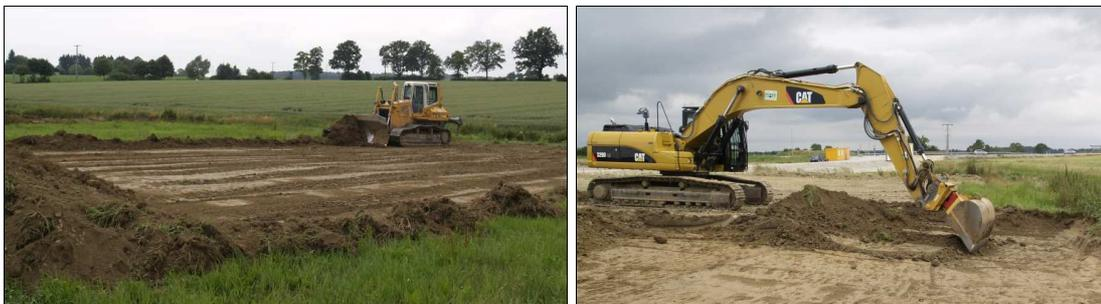
Abb. 13 Links: Humusabtrag mit der Raupe. Rechts: Feinplanie mit dem Kettenbagger.
