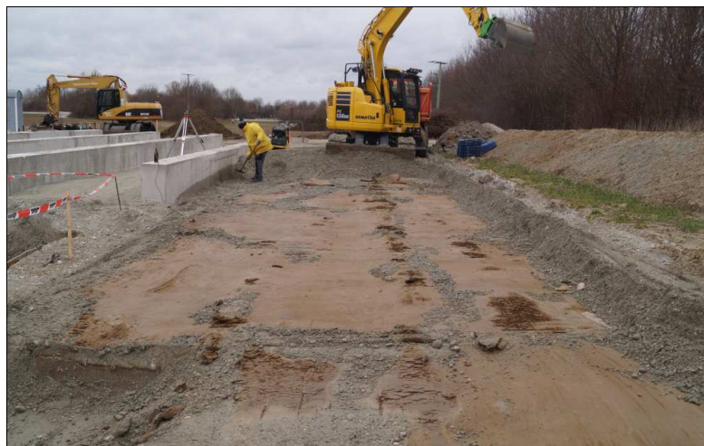
Abb. 20 Rückbau der konservatorischen Überdeckung in Fläche 2.
