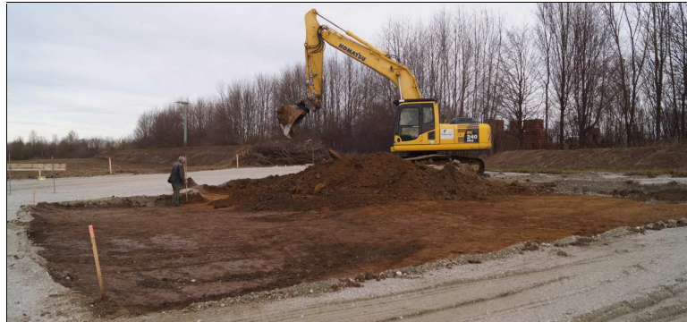
Abb. 8 Oberbodenabtrag des nördlichen Containerstellplatzes (Fläche 106).
