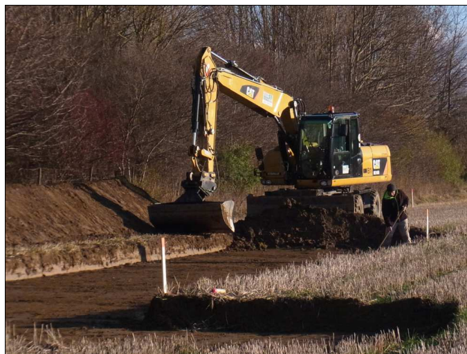
Abb. 7 Oberbodenabtrag der Straßen- und Wegtrassen durch Fa. F&S.
