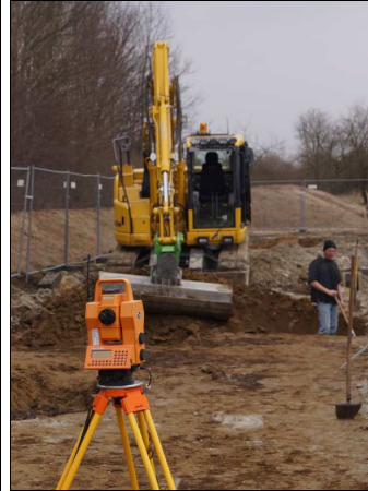
Abb. 13 Links: Fest- (FP) und Anschlusspunkte (AP) der Grabung. Rechts: Aufmaß mittels Totalstation.
