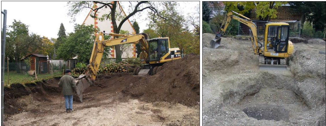
Abb. 9 Links: Oberbodenabtrag. Rechts: Anlage einer Rampe zum Brunnen Befund 47.
