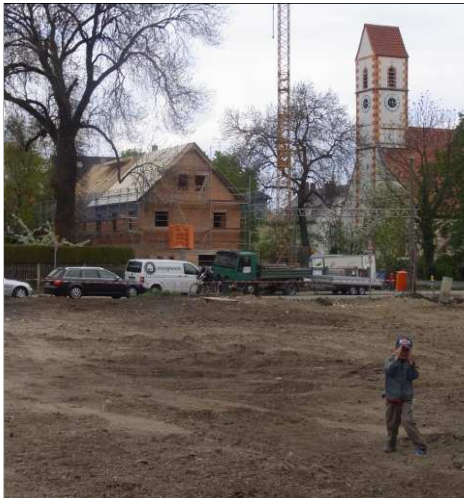
Abb. 46 Blick vom frisch planierten Grundstück Franz-Fihl-Str. 10 auf den Rohbau der Franz-Fihl-Str. 11.
