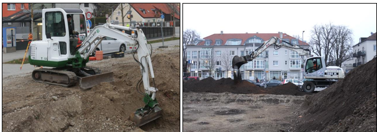
Abb. 10 Links: Minibagger der Archäologen. Rechts: Mobilbagger von Fa. Schmaus.
