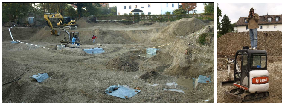
Abb. 11 Links: Bobcat Minibagger. Rechts: abgedeckte Brunnen knapp über Grundwasserniveau.
