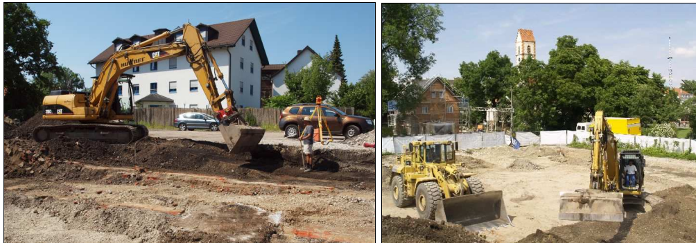
Abb. 9 Links: Oberbodenabtrag. Rechts: Bagger und Radlader legen Mieten an.
