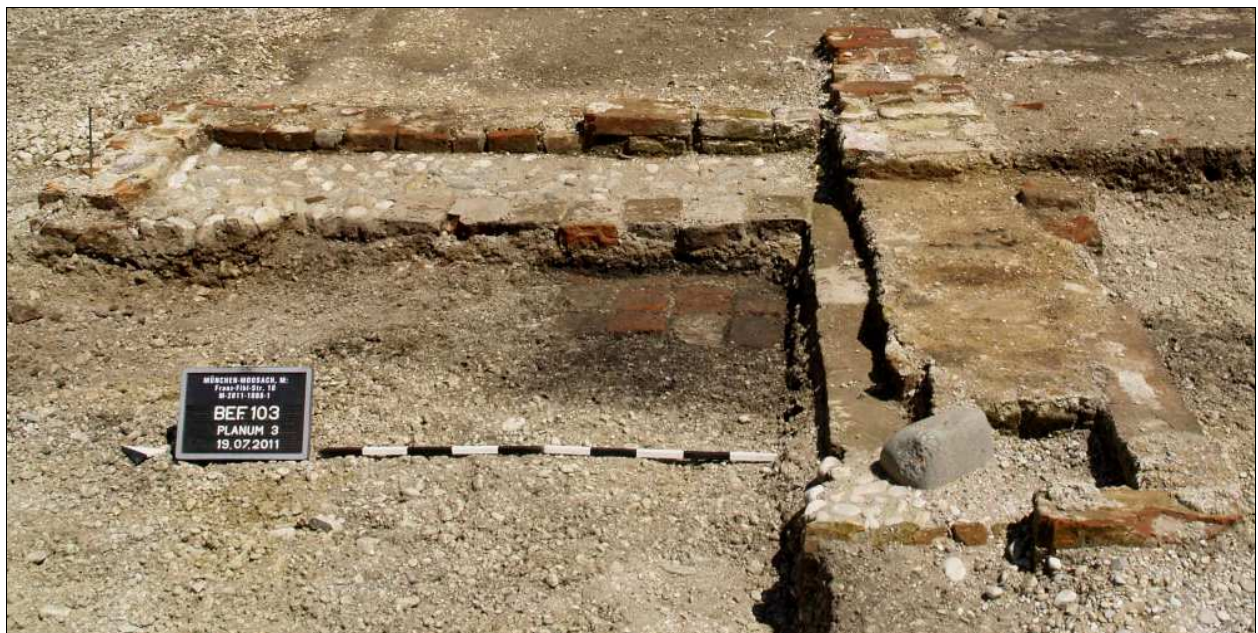
Abb. 50 Links: unter dem Pflaster Bef. 103 zu Tage kommendes, kleines Pflaster 481 en ONO. Rechts: Profil durch das Pflaster 481 und den älteren Pfosten Bef. 482 (vgl. Abb. 49).
