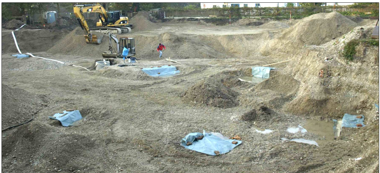
Abb. 56 Sicherung der Brunnenbefunde am 24.10. bis zur Einrichtung einer funktionierenden Wasserhaltung Anfang Dezember.
