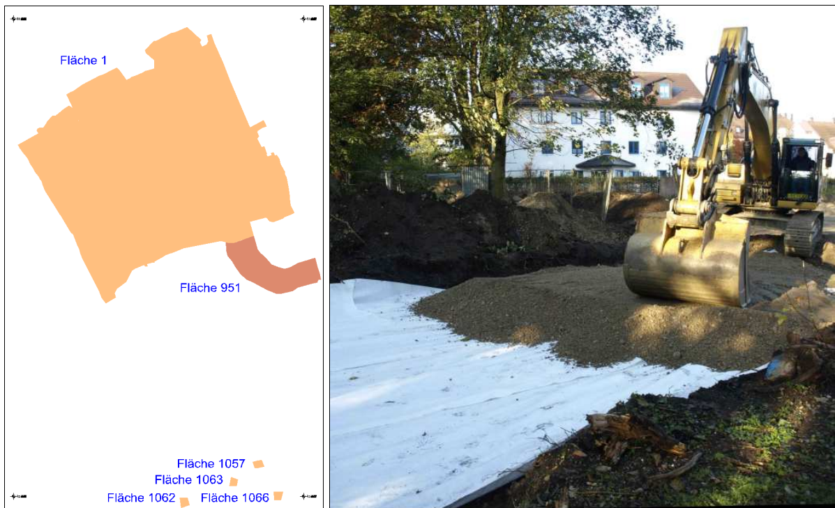
Abb. 22 Links: Flächennummern. Rechts: Überdeckung von Fläche 951 mit Geotextilvlies und Kies.
