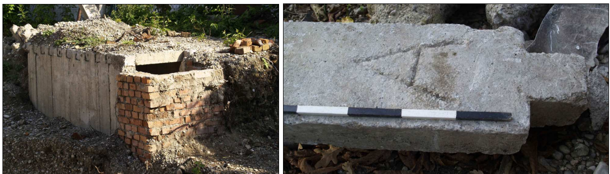
Abb. 8 Der aus Betonschwellen in den 1940er Jahren errichtete Schutzkeller.
