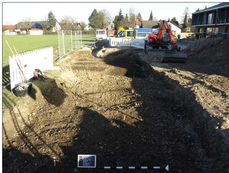
Abb. 3 Grabungsfläche unter dem Kiesweg mit dem im Osten zwischengelagerten Aushub.
