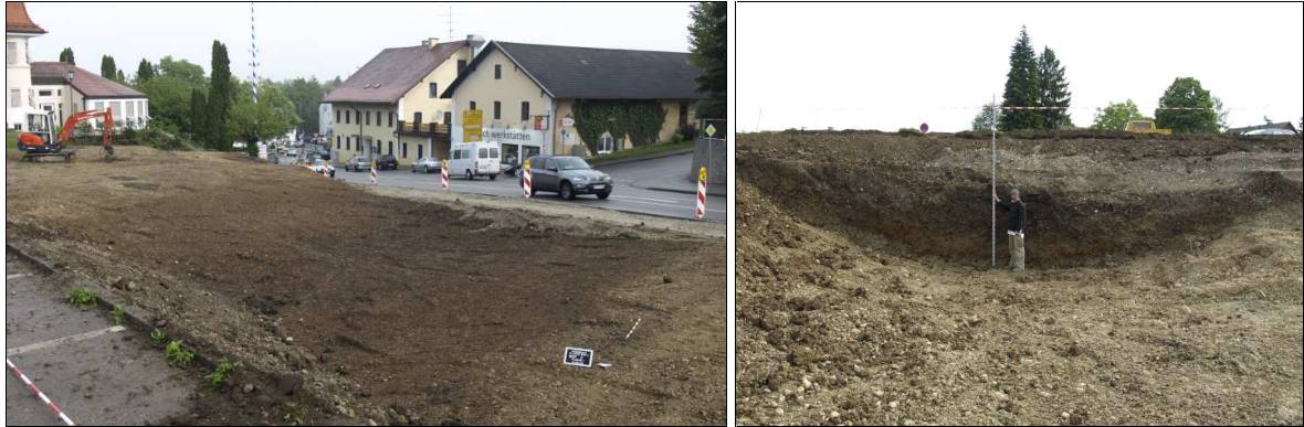
Abb. 22 Links: Planum 1 der Senke nach Ausbau rezenter Auffüllungen in Fläche 2. Rechts: Bis auf die Kiesoberfläche entnommene Verfüllung der Rinne am NO-Rand von Fläche 3.
