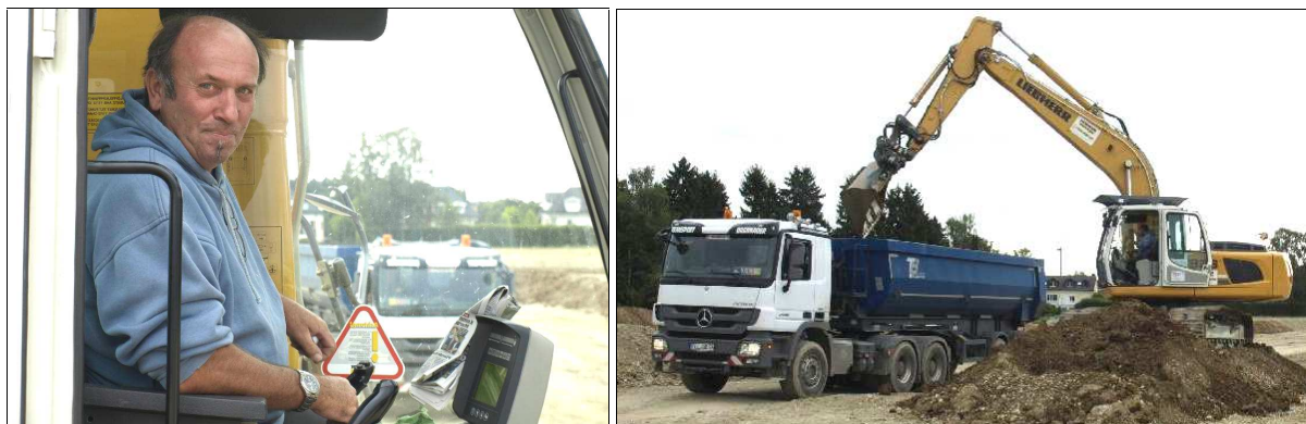
Abb. 5 Der Baggerfahrer – Herr Reindl – beim Verladen letzter Rotlagemieten des 2. Bauabschnittes.
