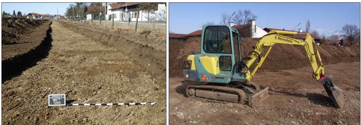
Abb. 7 Links: Abgezogener Streifen als Fahrstraße für den Abtransport. Rechts: Minibagger für die Anlage von Arbeitsgruben.
