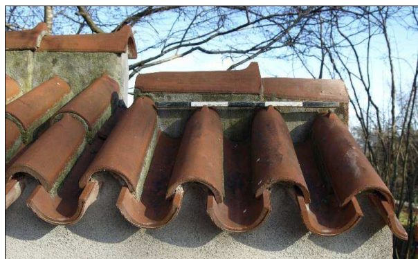
Abb. 32 Moderne Eindeckung mit Mönch/Nonne auf der Innenseite.
