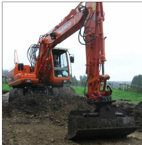
Abb. 9 Oberbodenabtrag mit dem 14t-Mobilbagger.
