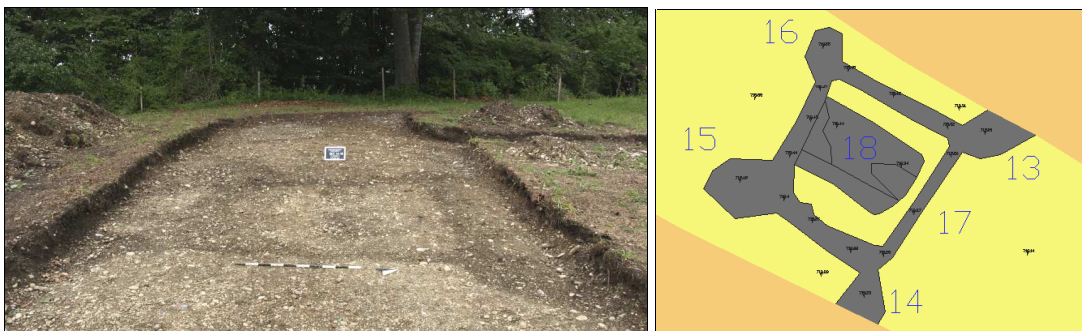
Abb. 21 Kernbau des Vermessungsturmes: Schwellbalkenkonstruktion mit Pfosten in den Ecken und zentraler Grube für trigonometrischen Punkt.
