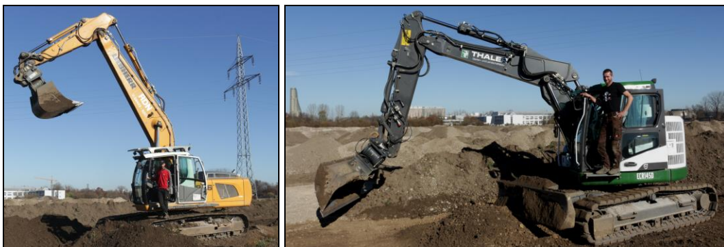
Abb. 7 Links: 29t-Liebherrbagger für den Humusabtrag. Baggerfahrer: Andreas Tischner. Rechts: 16t-Volvobagger für die Feinplanie. Baggerfahrer: Dietmar Vogler
