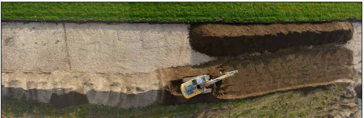
Abb. 2 Oberbodenabtrag. Links mit Pfostengruben, Gräbchen. Luftbild mit dem Hebedrachen.
