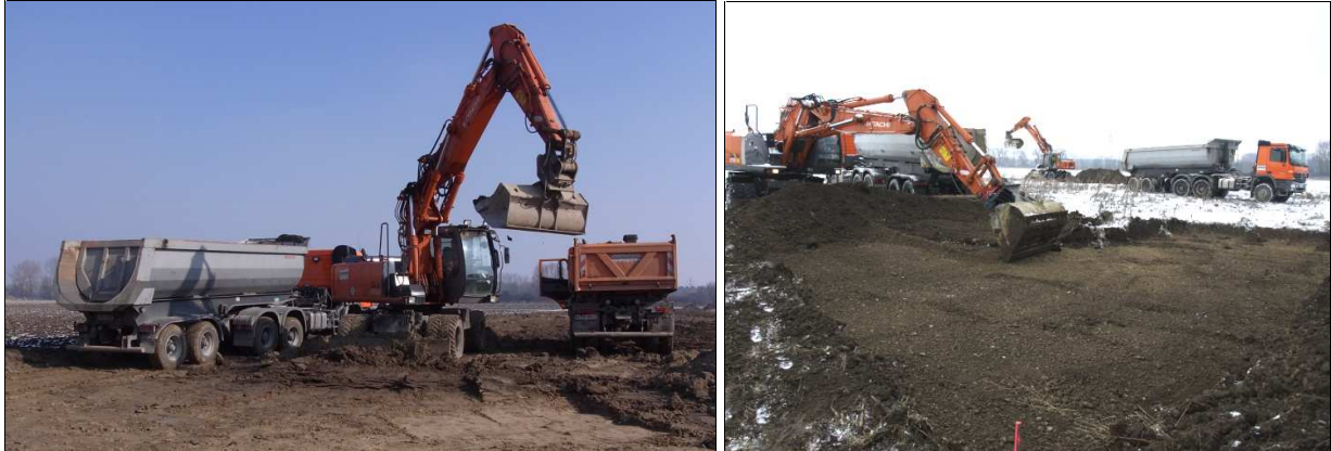
Abb. 6 Oberbodenabtrag mit den Mobilbaggern und LKWs.
