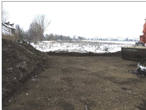
Abb. 7 Erdarbeiten: links im Bild die Aufschüttung für den Wall.
