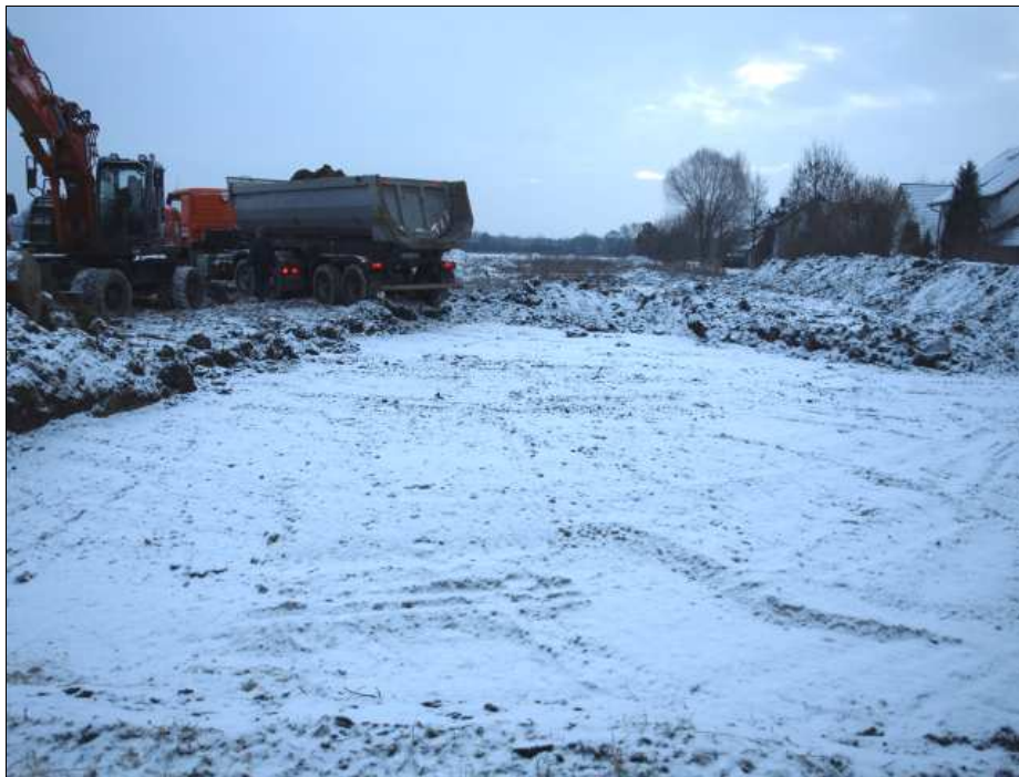
Abb. 24 Oberbodenabtrag bei frostigen Temperaturen.
