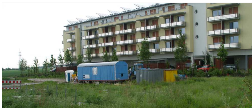
Abb. 4 Baustelleneinrichtung für die Verlegung der Gasleitung im NO-Teil (gegen NO).
