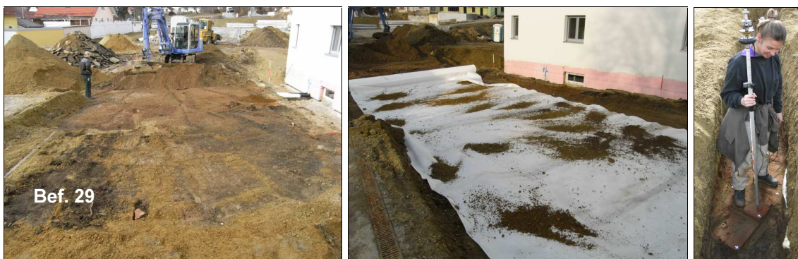
Abb. 20 Links, Mitte: Über dem Befundhorizont abgezogener und später wieder mit Flies überdeckter Vorplatz (Fläche 2) gegen Norden, NNO. Der Graben Bef. 1 war zu diesem Zeitpunkt bereits wieder verfüllt. Rechts: Einmessen der Passkreuze für die Photogrammetrie des Mauerbefundes 47.
