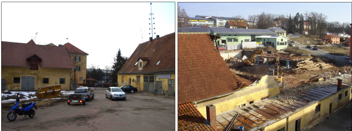
Abb. 14 Links: Brauereinebengebäude gegen Südosten (im Hintergrund das Wasserschloss). Foto: Städtebaulicher Ideenwettbewerb (Auslobungstext). Rechts: Abbrucharbeiten gegen Nordosten vom Wasserschloss aus. Foto: Herr Herzig.
