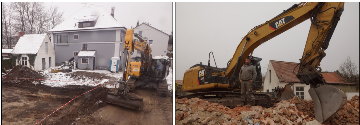
Abb. 9 Erd- und Abbrucharbeiten mit verschiedenen Baggern.
