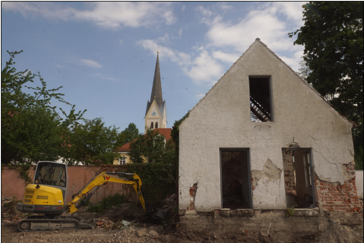
Abb. 11 Arbeiten mit dem Minibagger am ehemaligen Wasch- und Gartenhaus.
