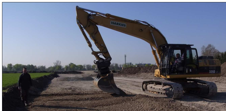
Abb. 22 Feinplanie mit dem Kettenbagger.
