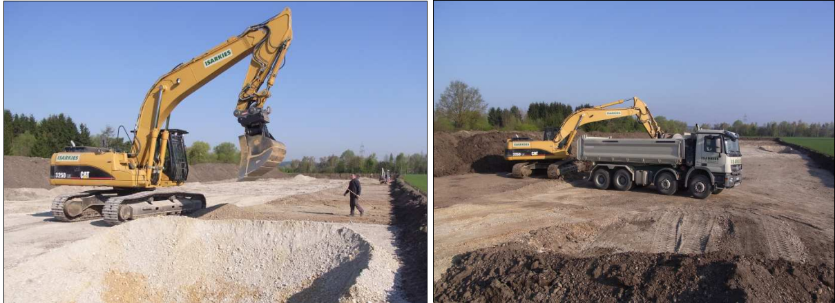
Abb. 6 Links: Feinplanie unter fachlicher Aufsicht. Rechts: Abtransport des anfallenden Materials.
