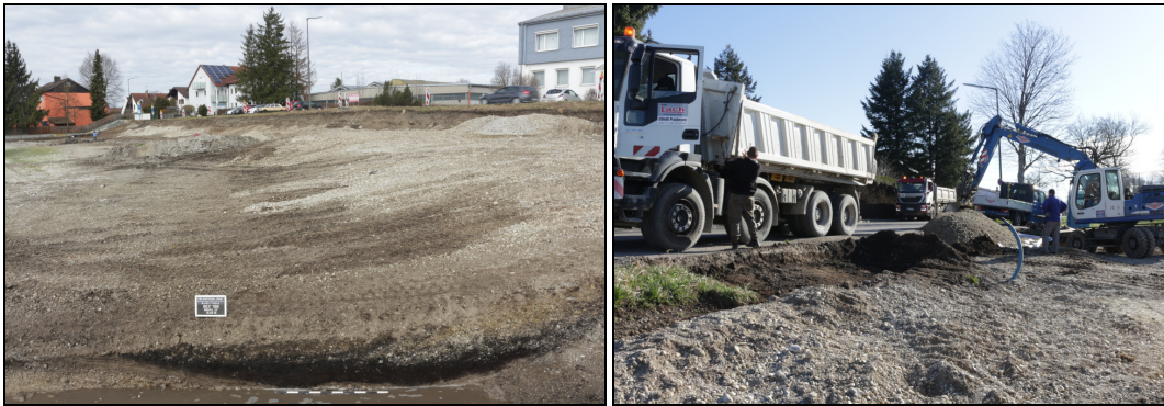
Abb. 5 Links: eines der Profile durch die Senke am Hangfuß. Rechts: Einrichtung einer Baustellenzufahrt.
