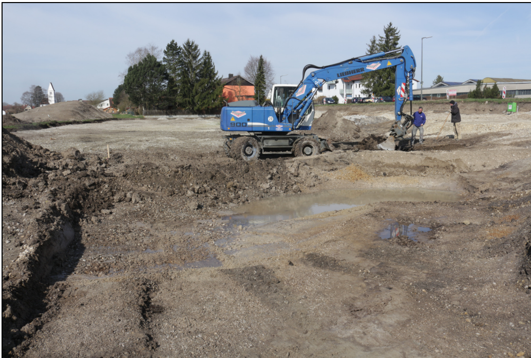
Abb. 6 Ausbau der Senke unter archäologischer Begleitung.
