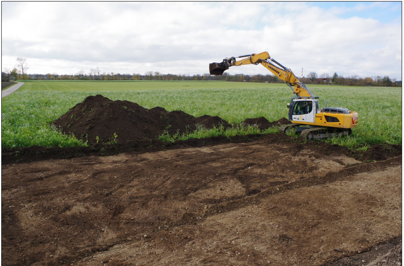
Abb. 4 Oberbodenabtrag. Rechts vorne: fertig abgezogener Streifen. Im Mittelgrund: Zwischenplanum.
