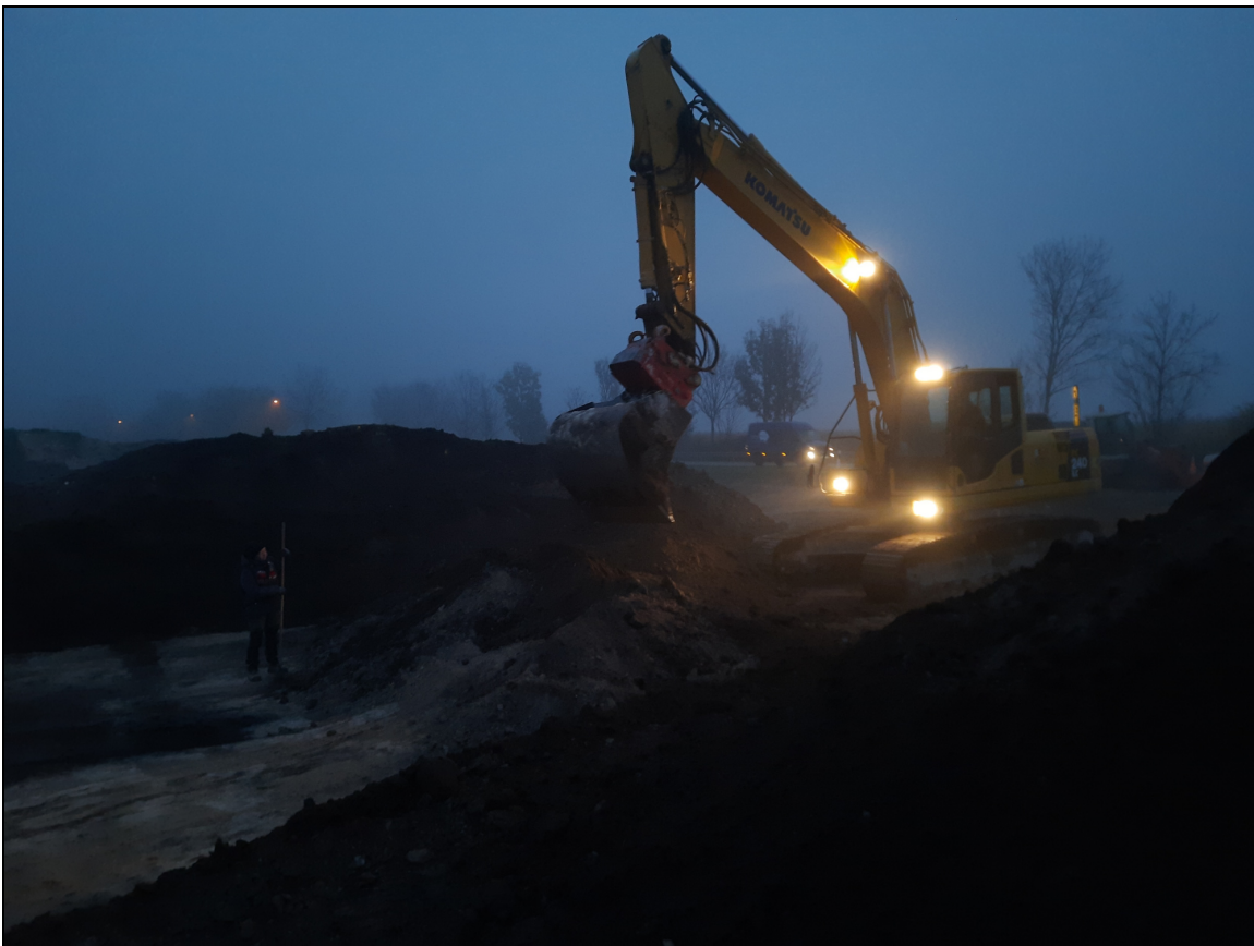
Abb. 1 Früh am Morgen: Oberbodenabtrag von Fa. Fehlberger unter archäologischer Aufsicht.
