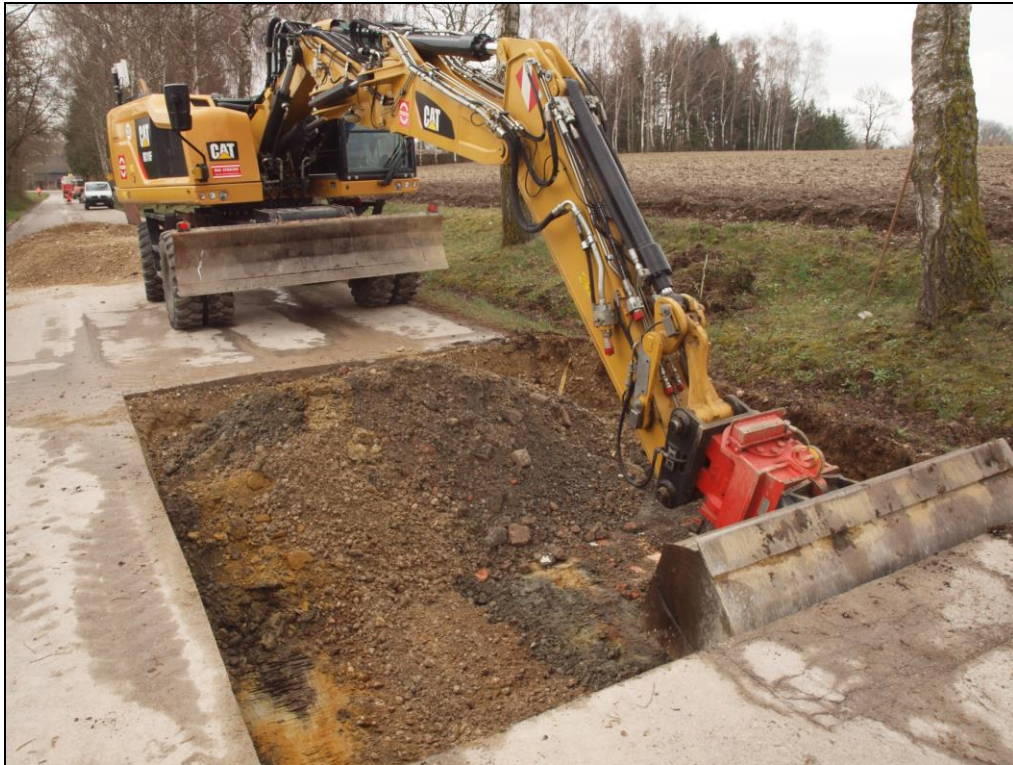
Abb. 5 Ausbau des Kieskoffers nach Entfernung der Teerdecke (Schnitt 6).
