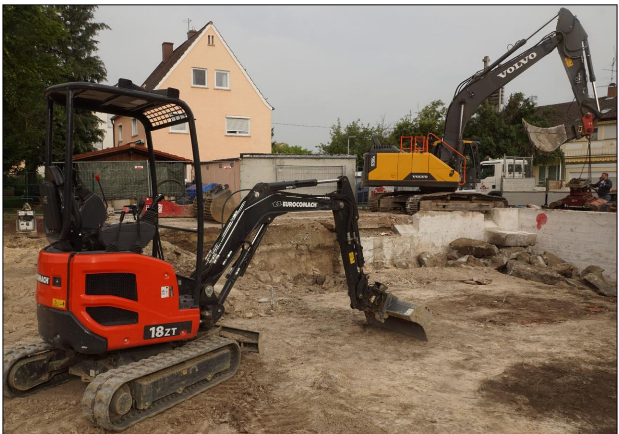
Abb. 4 Arbeitsfoto gegen NW mit den beiden Baggern.
