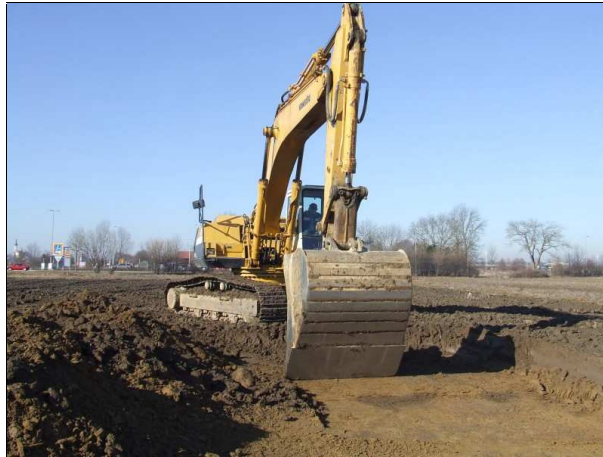
Abb. 12 Oberbodenabtrag mit dem Kettenbagger.
