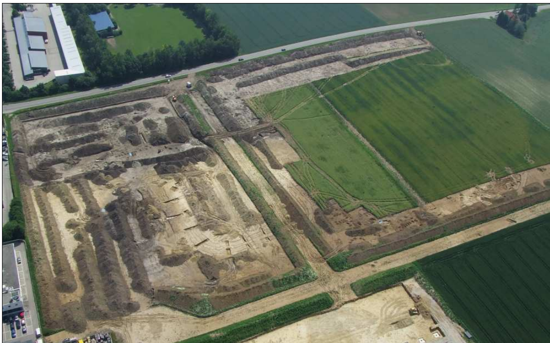
Abb. 13 Rollierender Oberbodenabtrag auf den Flächen 258 und 259 gegen OSO (24.06.2006).
