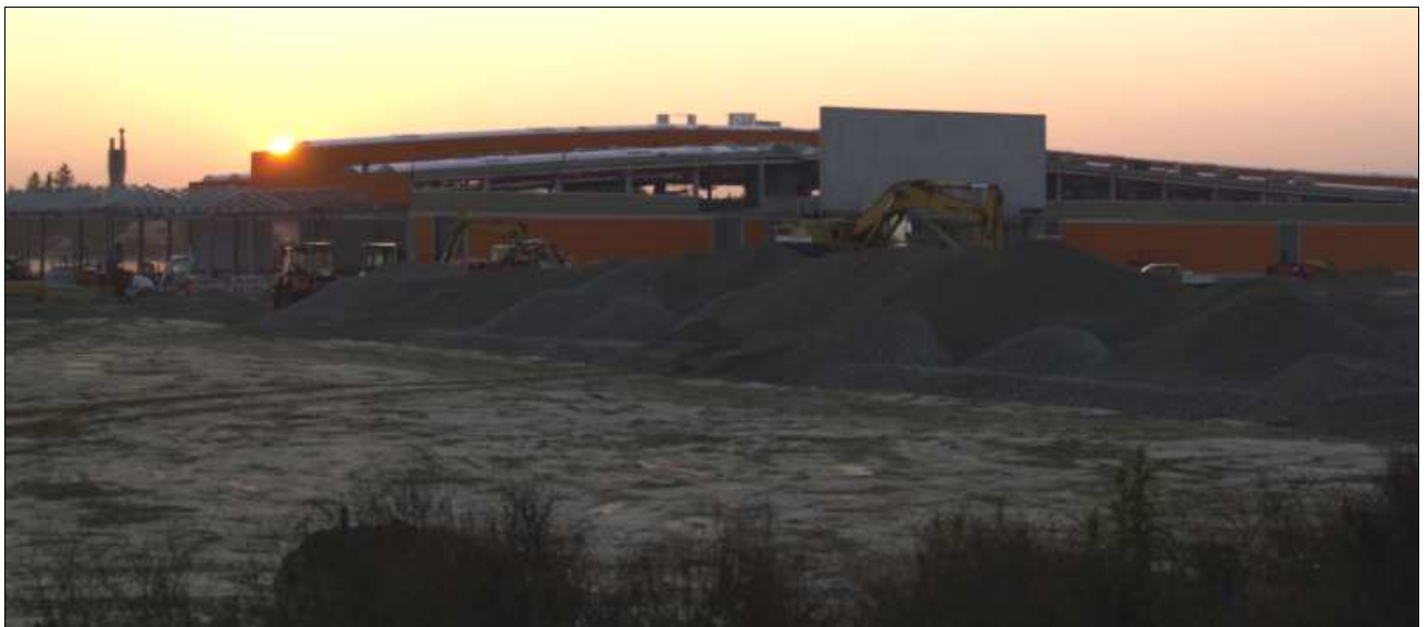
Abb. 111 Parallel zur Grabung haben die Bauarbeiten bereits begonnen.
