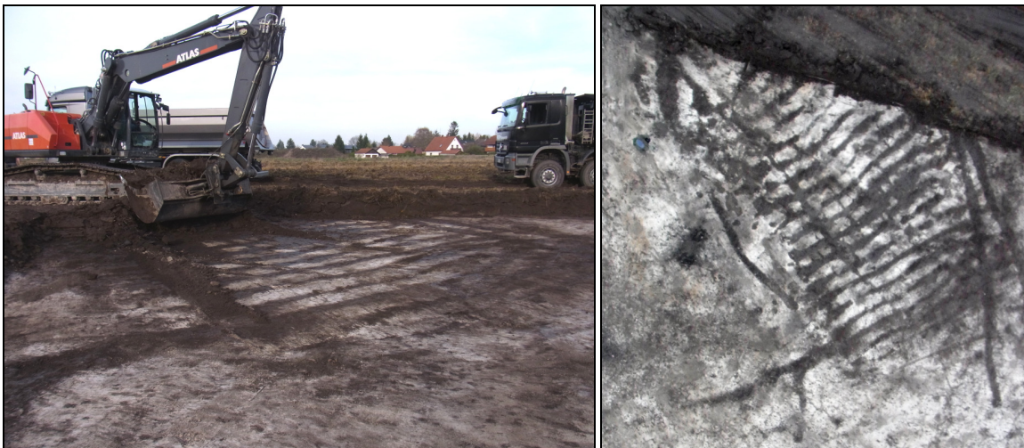
Abb. 4 Gitterartige Struktur: rezente Drainagemassnahme?
