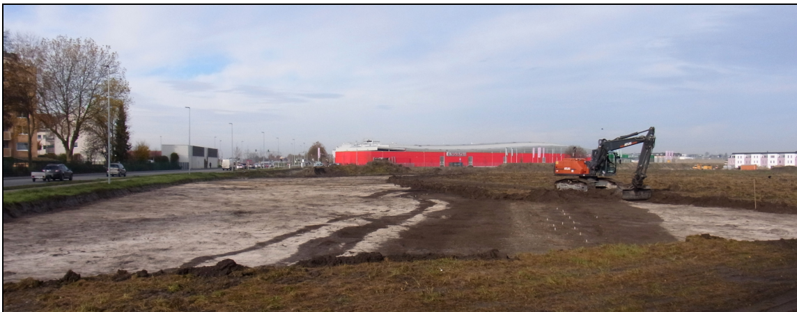
Abb. 5 Der Oberbodenabtrag an der Dachauer Straße hat begonnen.
