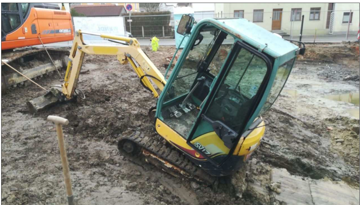
Abb. 6 Minibagger – mit Mühe die durch Regen aufgeweichte Rampe erklimmend.
