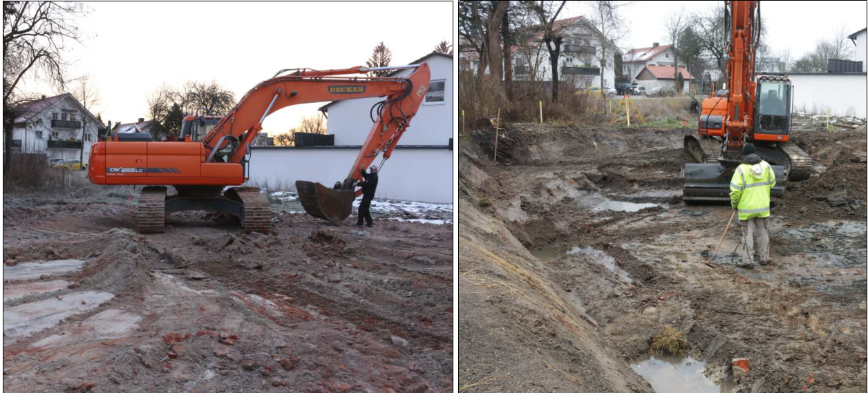
Abb. 5 Links: Doosan-Kettenbagger mit Grabraumlöffel. Rechts: Anlage des 3. Planums mit schwenkbarer Humusschaufel
