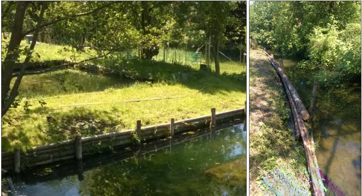
Abb. 27 Beispiele für rezenten Uferverbau aus Nadelholz südlich von Isen (links Fischeiche, rechts Isen).
