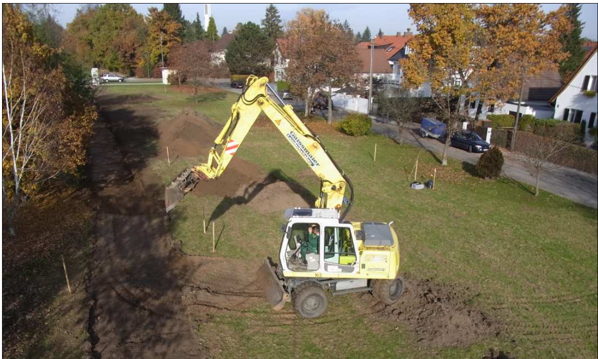
Abb. 4 Erdarbeiten im Bereich der Fußwegtrasse (Aufnahme vom 7m-Stativ).
