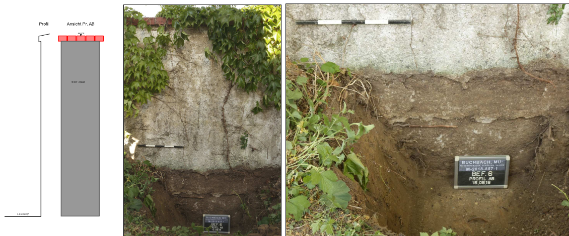
Abb. 20 Links: CAD-Mauerprofil der Schürfe 6 im M. 1:50. Mitte, rechts: Profilansicht 6AB gegen Osten
