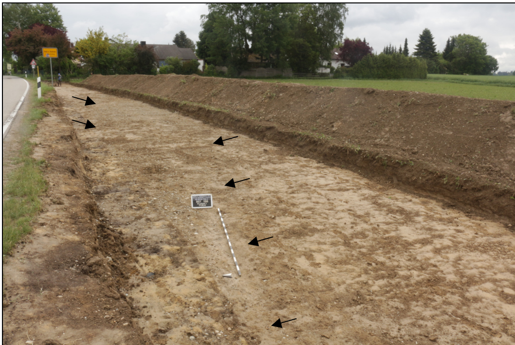
Abb. 2 Fläche für den neuen Radweg am westlichen Ortsausgang mit Grabenverfüllung der Gasleitung (links) und Resten des Kieskoffers der alten Straße (Pfeile).
