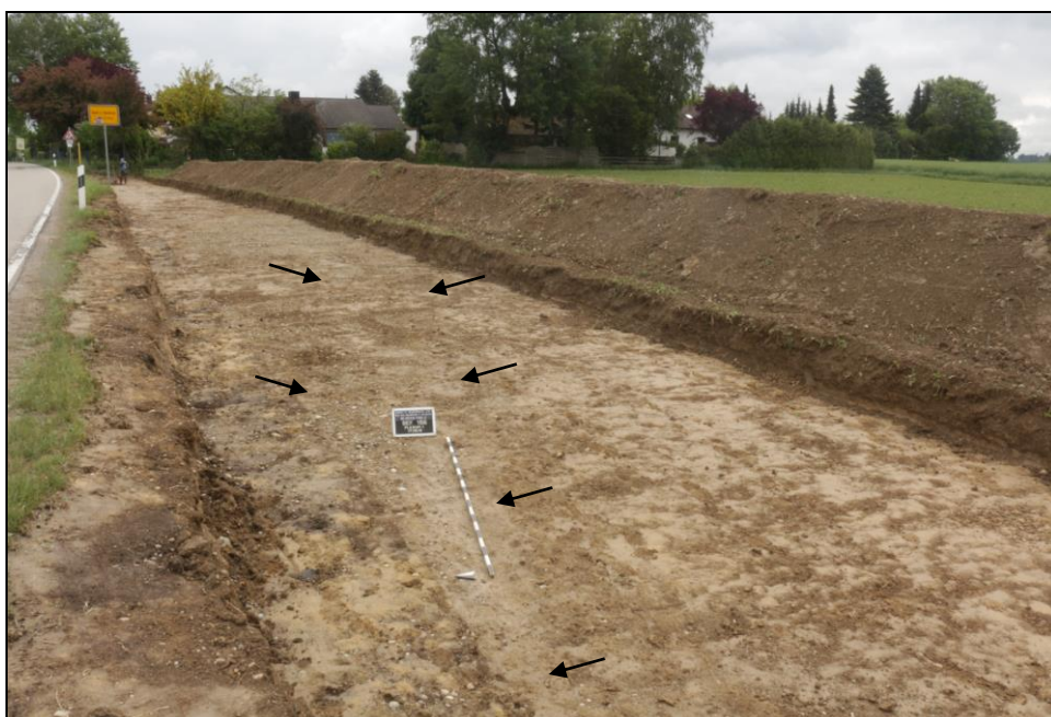
Abb. 44 Fläche für den neuen Radweg am westlichen Ortsausgang mit Grabenverfüllung der Gasleitung (links) und Resten des Kieskoffers der alten Straße (Pfeile).
