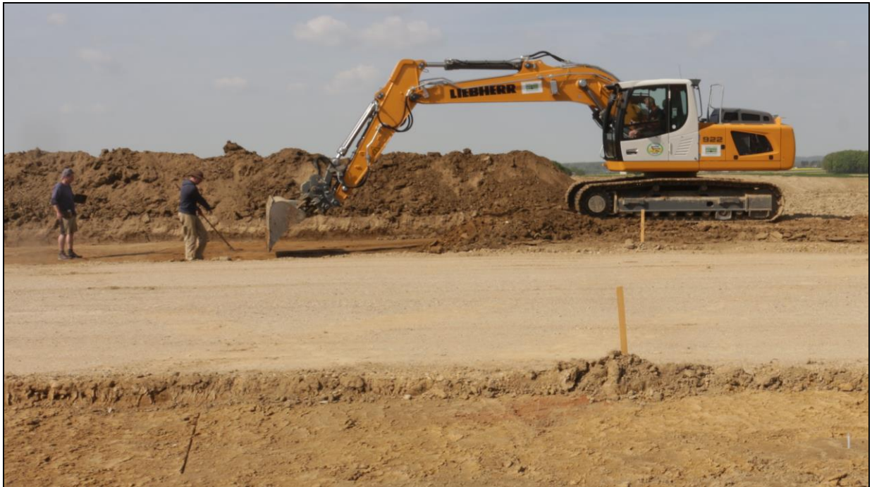
Abb. 6 Oberbodenabtrag durch Fa. Brandl. Im Vordergrund die aufgekieste Erschließungsstraße.
