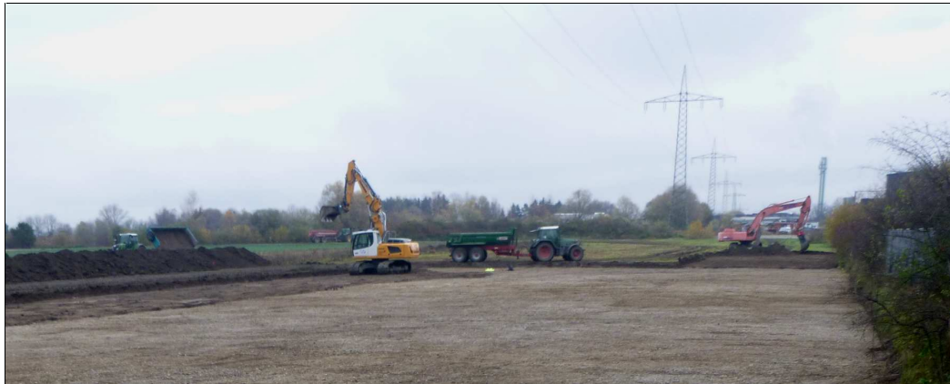
Abb. 6 Übersicht über Baufelder 1 und Fläche Brummer gegen Südosten. Links Rotlageabtrag in Baufeld 1. Rechts: Humusabtrag im Grundstück von Herrn Brummer.
