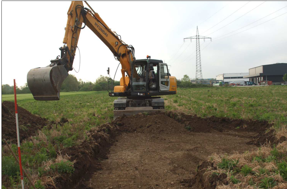
Abb. 7 Beginn des Oberbodenabtrages.
