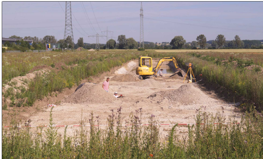
Abb. 10 Die Fläche gegen Ende der Grabungsarbeiten.
