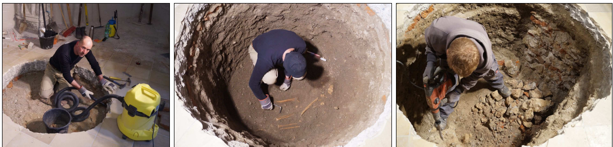
Abb. 5 Links, Mitte: Freilegung archäologischer Plana. Rechts: Mauerabbruch mit dem Bohrhammer.
