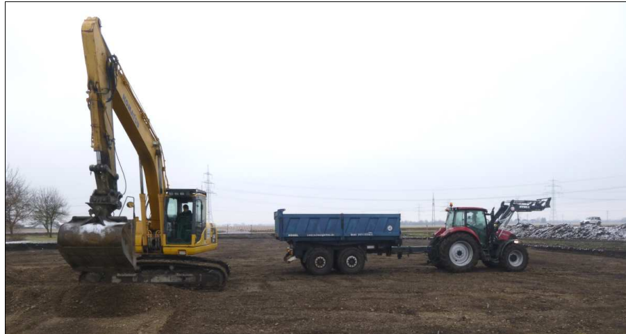
Abb. 6 Humusabtrag bis auf den Mischhorizont.
