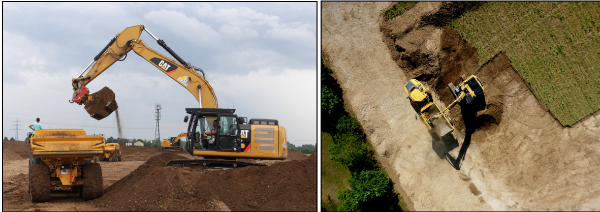
Abb. 1 Verladen des Humus auf Volvodumper. Rechts: Luftbild mit dem Hebedrachen.
