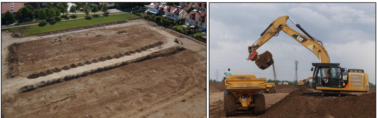
Abb. 6 Links: Fahrstraßen und Areale, die bis auf den Mischhorizont abgezogen wurden (© Stefan Kluthe). Rechts: Umsetzen des Humus auf die Miete am Südrand mit Hilfe von Volvo-Dumpfern.
