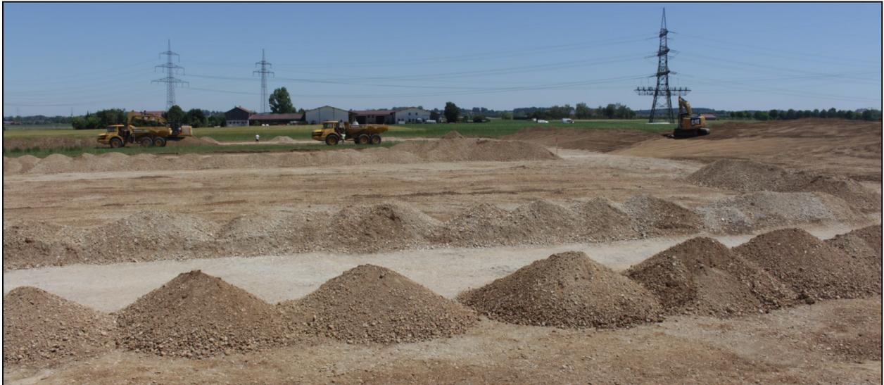
Abb. 7 Arbeitsfoto gegen Osten. Vorne: abgezogene Teilflächen mit zwischengelagertem Mischhorizont. Rechts: Bagger beim modellieren der Humusmiere. Im Hintergrund Humusabtrag.
