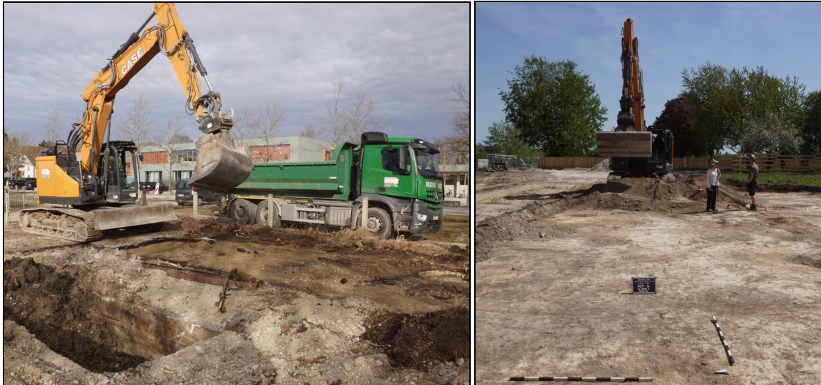
Abb. 1 Links: Rückbau der Asphaltdecke im Nordostteil. Rechts: Feinplanie bis auf die Oberkante des anstehenden Alms.
