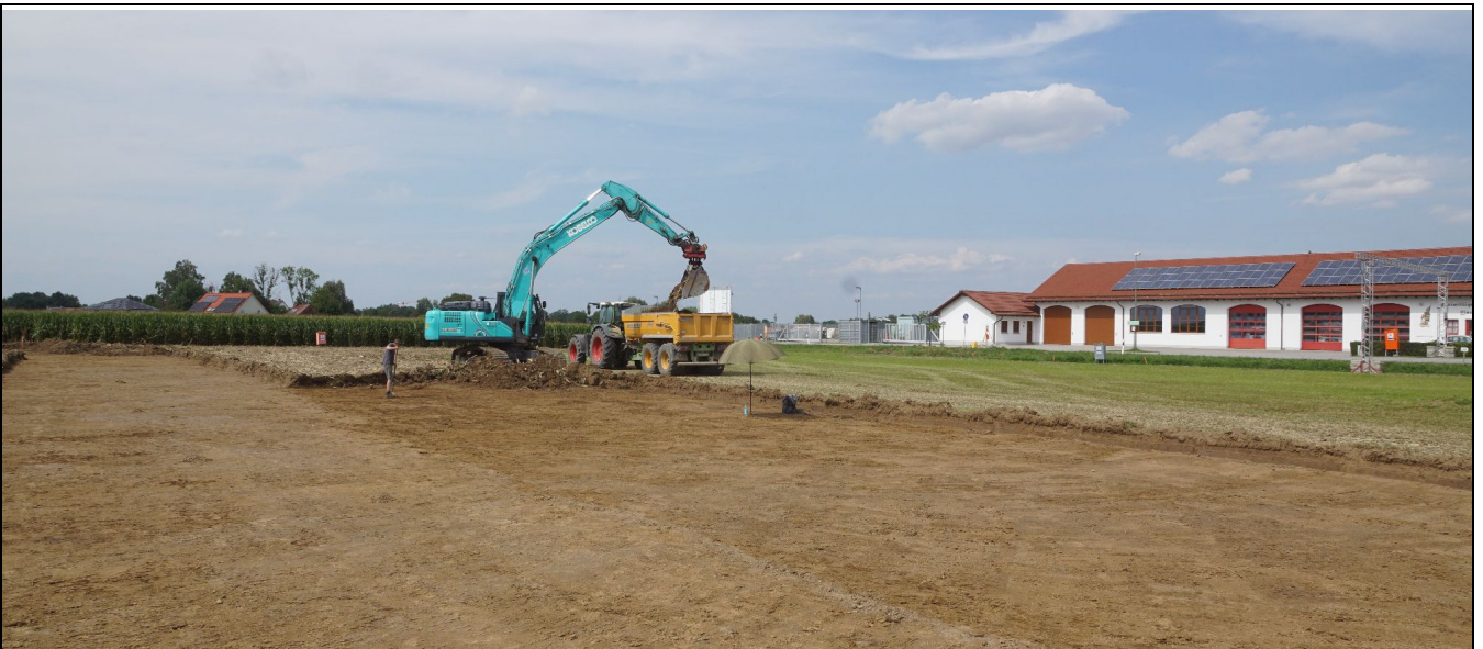
Abb. 2 Oberbodenabtrag: Abtransport des Mutterbodens mit Traktoren.
