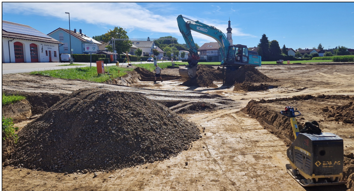
Abb. 12 Fließender Übergang zwischen Grabung und Bebauung: das 2. Planum des verfüllten Hohlweges wird bereits überkiest.
