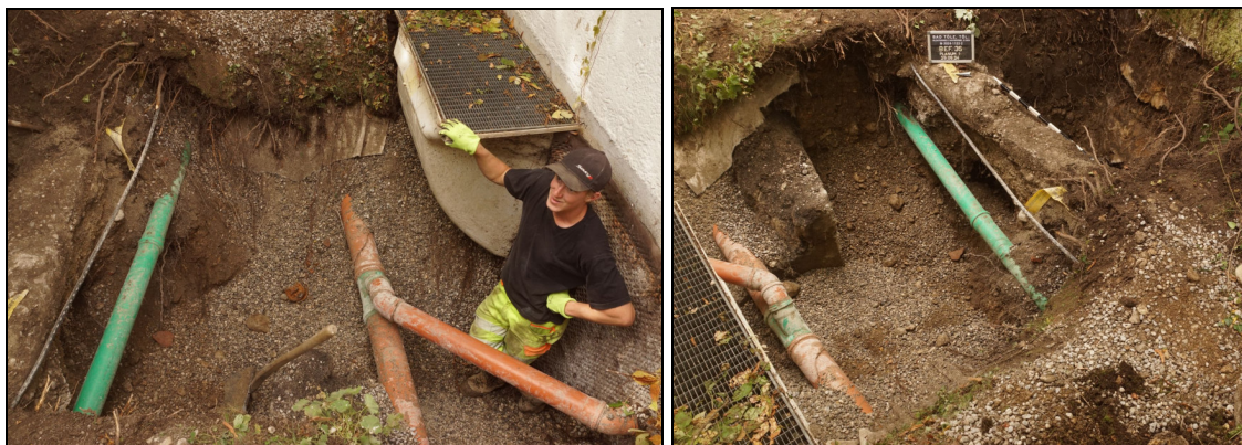
Abb. 17 Fläche 34 mit Kiesriesel, Leitungen, Betonfundamenten.
