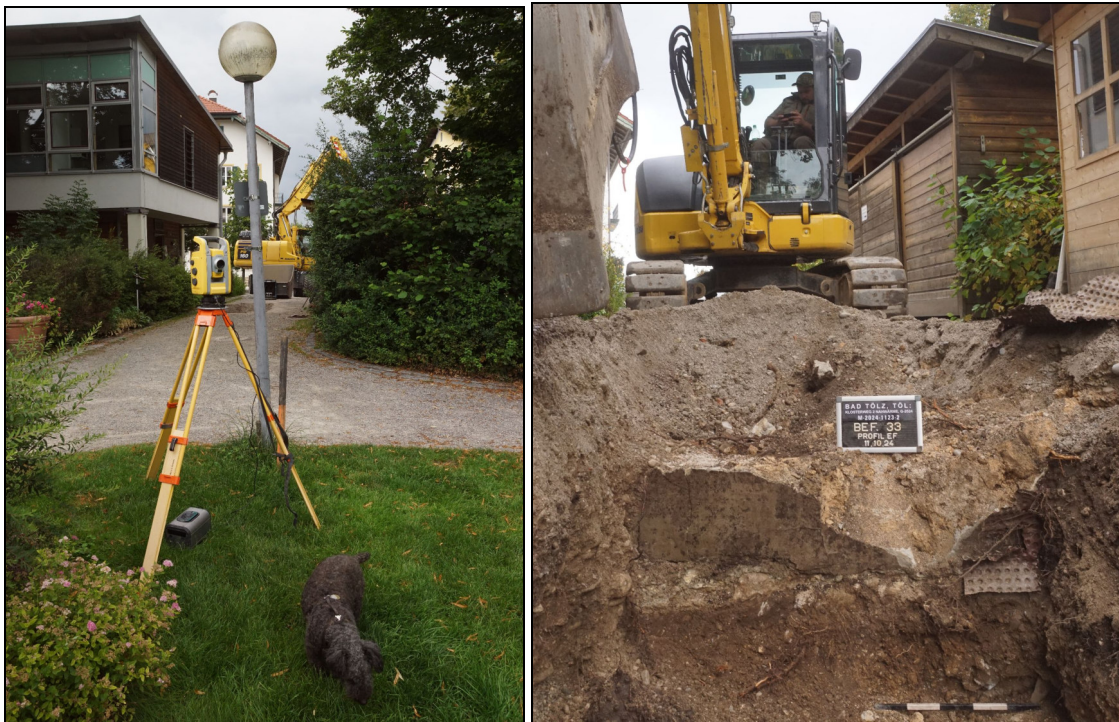
Abb. 27 Links: Zugang zum Rosengarten zwischen Badstraße 15 und Max-Höfler-Platz 1a. Rechts: Reste der abgebrochenen Friedhofsmauer Bef. 33 (mit Noppenfolie) unter dem Weg.
