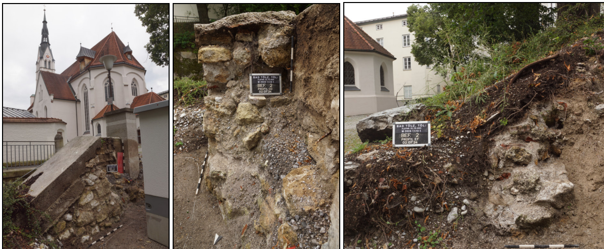
Abb. 4 Mauer 2. Links: Ansicht im Bereich des Treppenabganges gegen NW. Mitte: Profil mit gut erkennbarem Aufbau gegen SSO. Rechts: im Hang am NNW-Rand der Baugrube.
