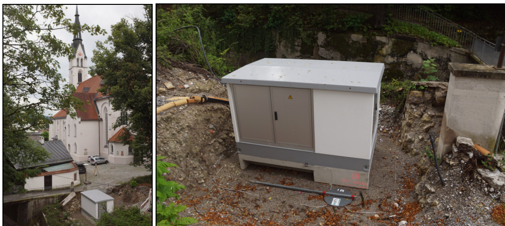
Abb. 2 Die Baustelle zum Maßnahmenbeginn am 02.07.2024.
