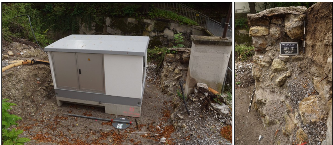
Abb. 6 Trafostation und teilweise abgetragene Mauer Bef. 2 am 2. Juli 2024.
