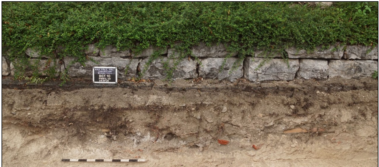
Abb. 33 Profil 10 CD mit Trockenmauer Bef. 5 zur Hangbefestigung des höher gelegenen Parkplatzes.
