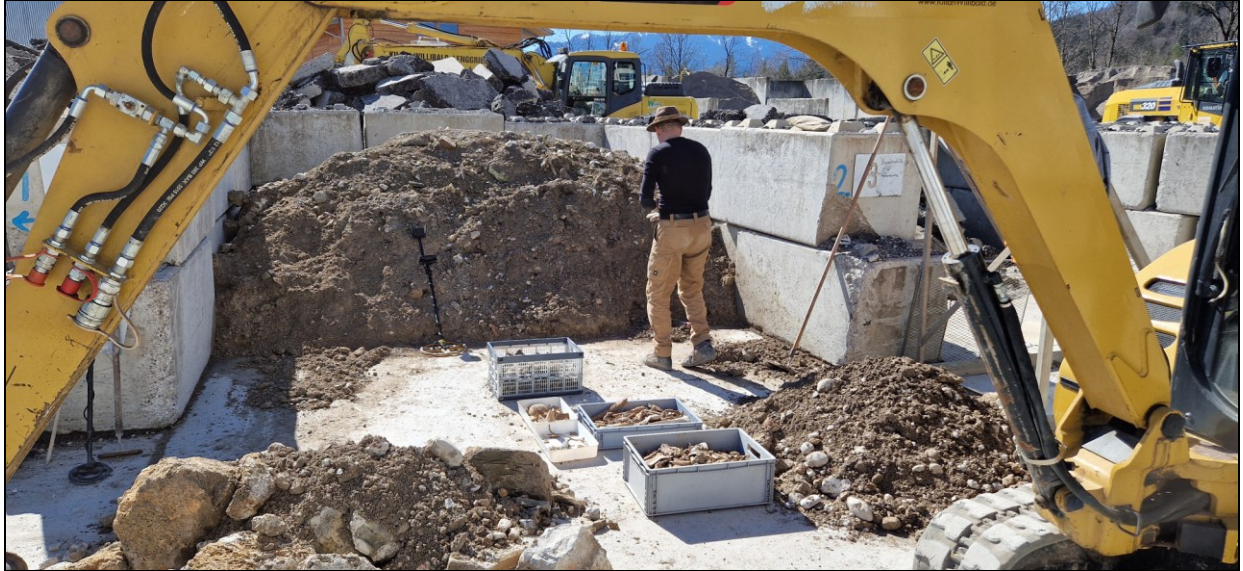
Abb. 9 Durchsuchen des Aushubes von der Trafostation auf dem Firmengelände von Fa. Willibald.
