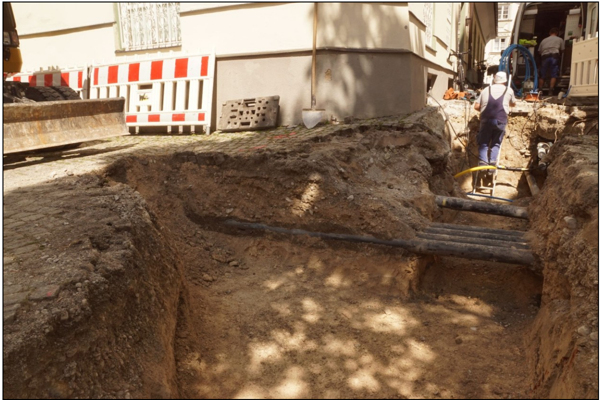
Abb. 25 Blick nach Norden in Fläche 32 während der Schweißarbeiten an der Gasleitung. Im Vordergrund ältere Leerrohrtrasse.
