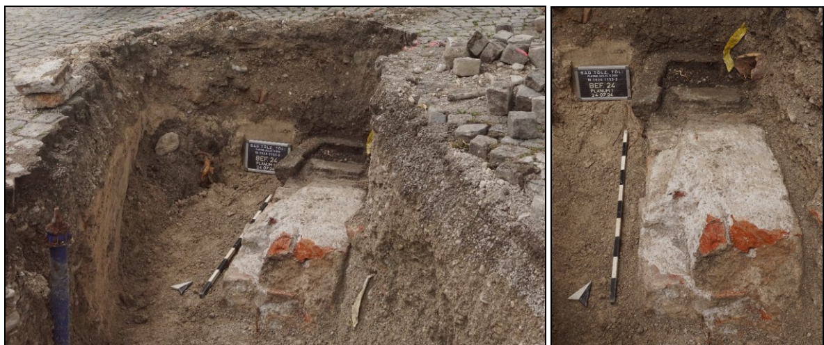
Abb. 28 Fundament Bef. 28 mit jüngerem Betonschacht der Regenentwässerung des Straßenwassers.
