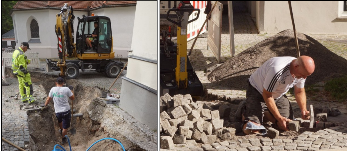
Abb. 7. Die Mitarbeiter von Fa. Willibald v.l.n.r.: Herr Peter Neunzer (LKW-Fahrer), Herr Martin Grgic (Bauhelfer). Herr Toni Demmel (Baggerfahrer), Herr Christian Roth (Pflasterer). Nicht am Bild: Herr Bodo Dreisbach (Bauleiter), Herr Josef Wenig (Polier).
