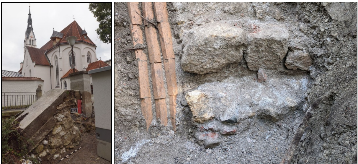
Abb. 32 Links: mit Beton überfangene Mauer Bef. 2 gegen Nordwesten. Rechts: Durch Stromleitungen Bef. 38 gestörtes Fundament Bef. 39.
